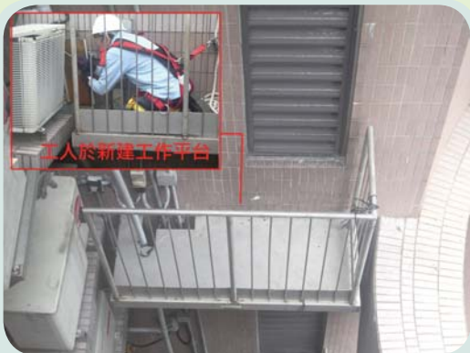
高衛得到業主支持，於大廈外牆加建工作平台，保障工人於外牆進行維修工作的安全。
