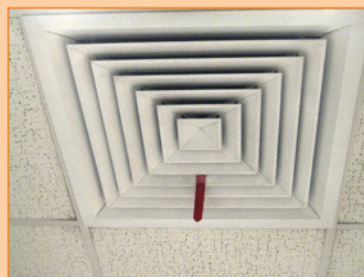
風口的送風紙條，顯示出風情況
